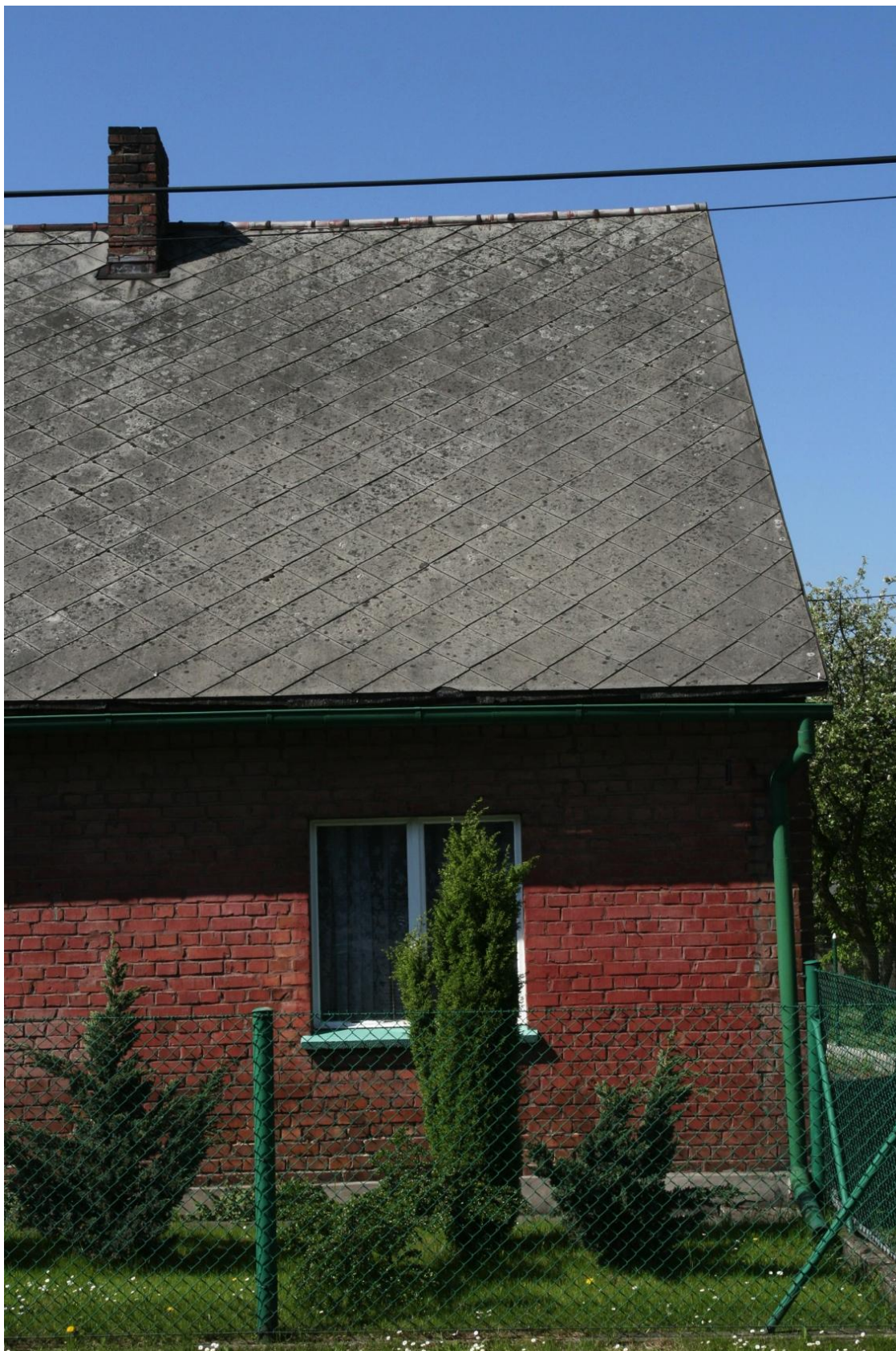
Rysunek 5 Dach budynku mieszkalnego pokryty płytami azbestowymi płaskimi Fotografia Agnieszka Chylak
